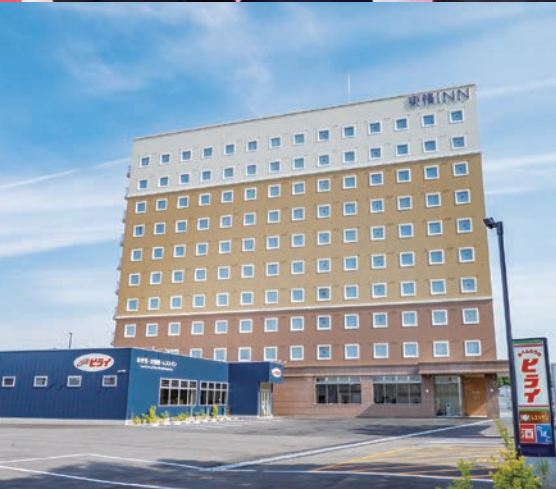
2025年6月竣工 Completed in Jun. 2025 東横INN熊本空港 Toyoko Inn Kumamoto Airport
